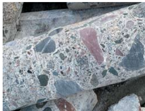
Рис. 1. Керны, отобранные из бетона конструкций плотины
